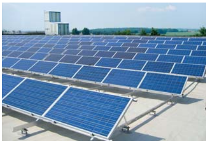
Befestigung direkt im Betondach
