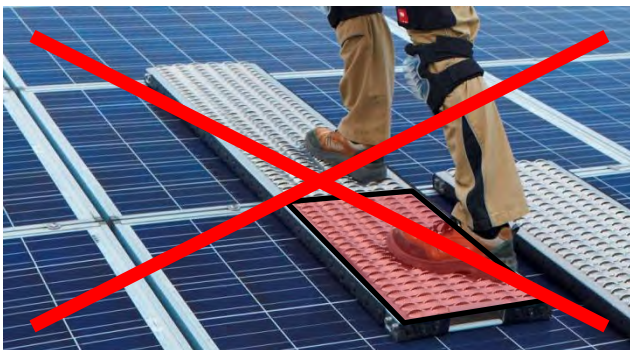
Abb. 6: Falsches Belasten des SMB SOLAR-MULTIBOARD's
