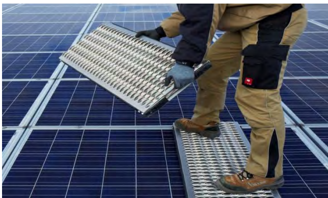
Abb. 7: Verlegen der SMB SOLAR-MULTIBOARD's
