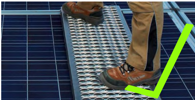
Abb. 5: Richtiges Belasten der SMB SOLAR-MULTIBOARD's
